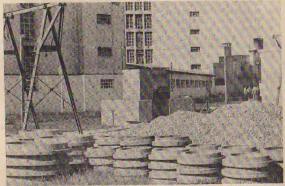
Construcción de bloques de hormigón en la Unidad 1, Olmos.
