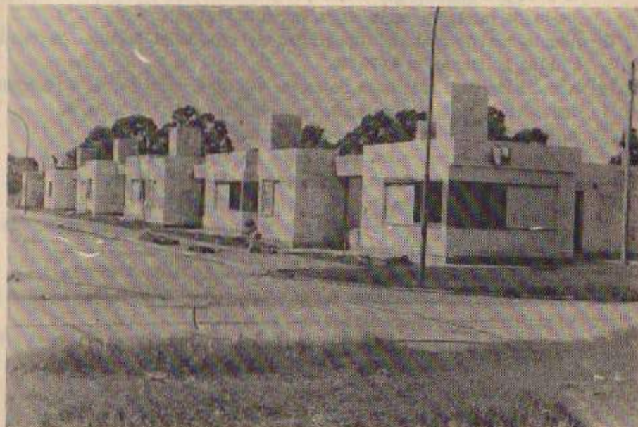
Vista parcial de la construcción del barrio de suboficiales en la Unidad 13, Junín.
