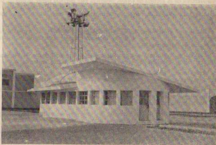
Una vista exterior de la Oficina de Control de la Unidad 2, Sierra Chica.
