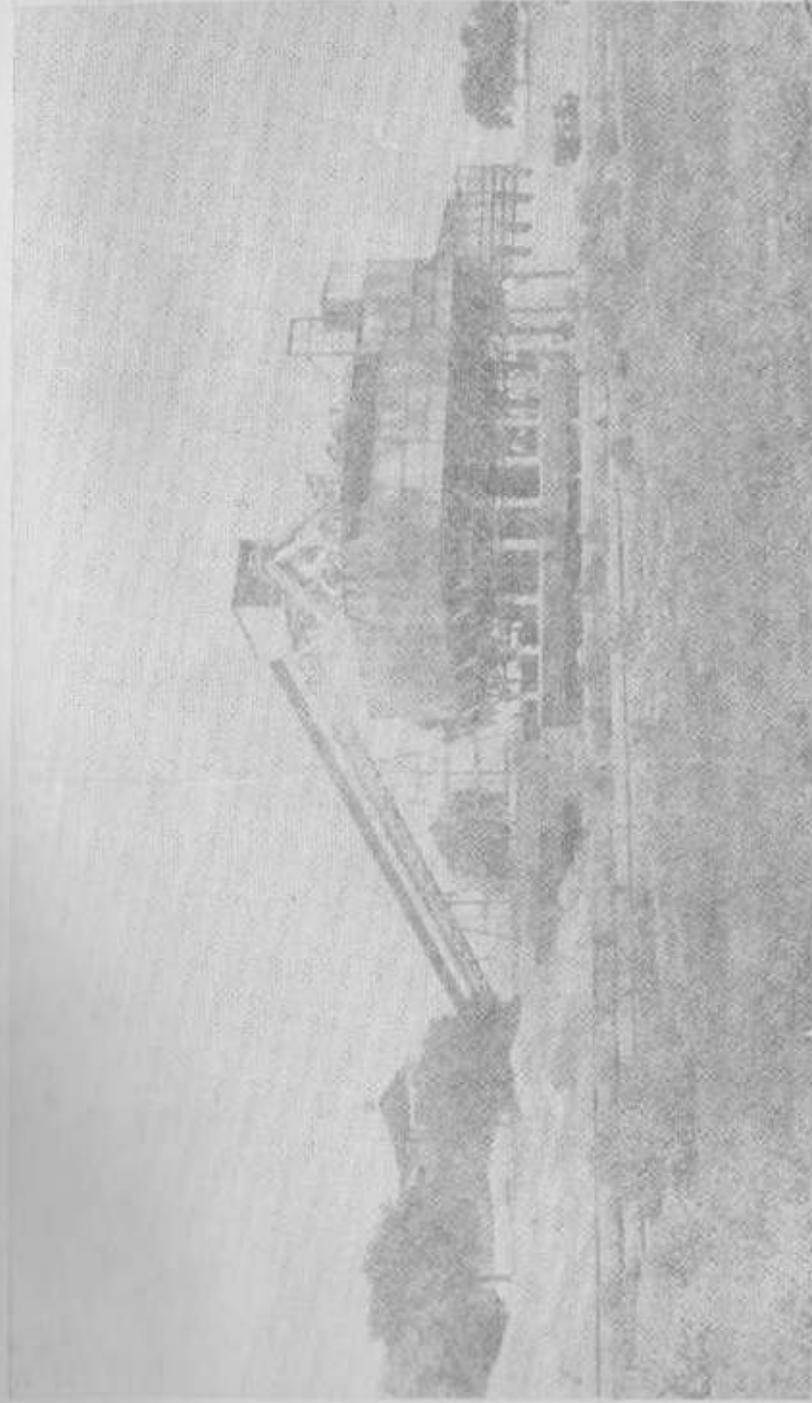
Zona de canteras: Trituradora con cinta sinfin, para elevación de la piedra (v. plano señal 10)
